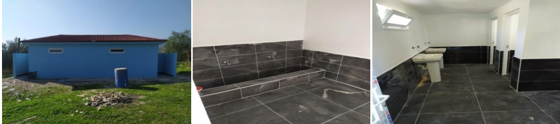
İsebalı mahallesine WC ve şadırvan yapımı
