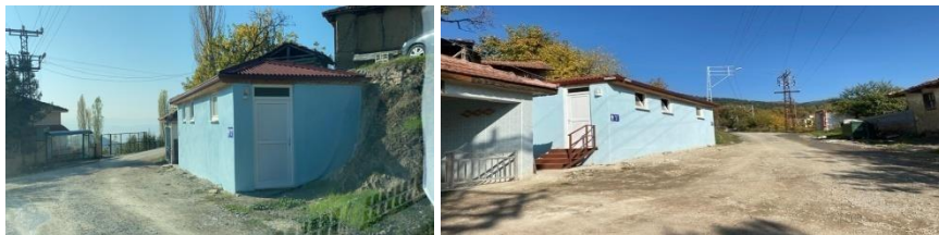
Kadıköy mahallesine wc yapımı
